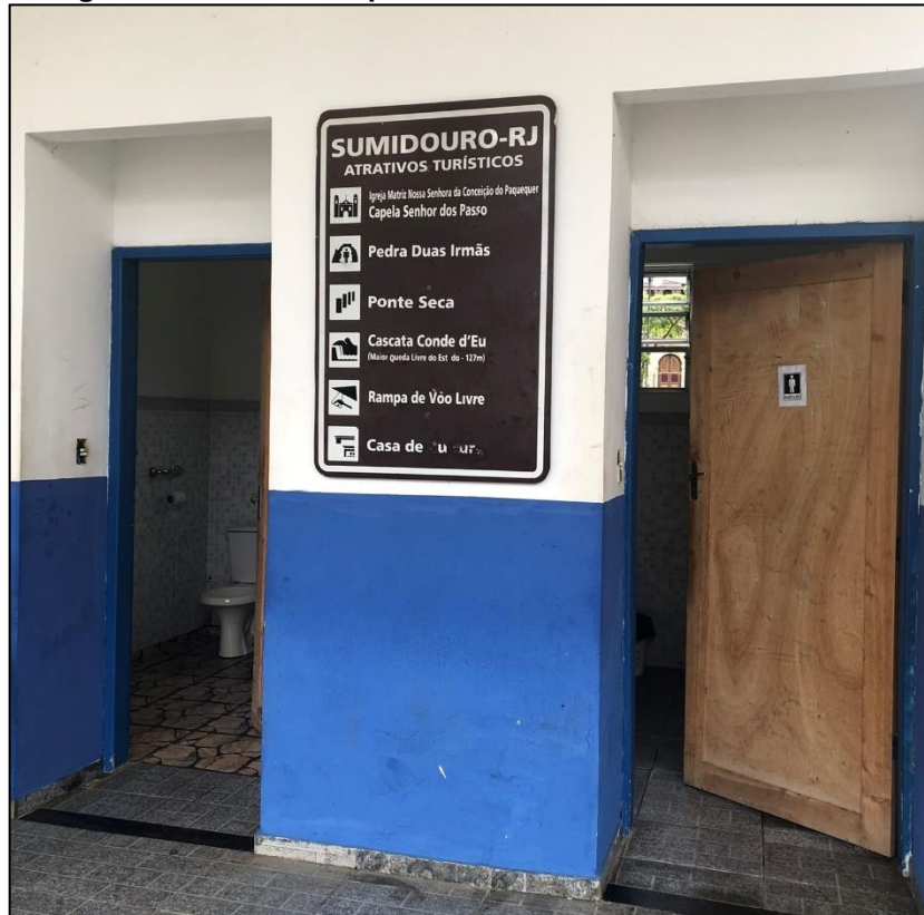
Figura 82 – Sanitários públicos da rodoviária de Sumidouro
