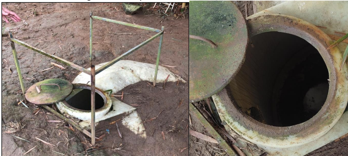
Figura 62 – Tanque de armazenamento de chorume
