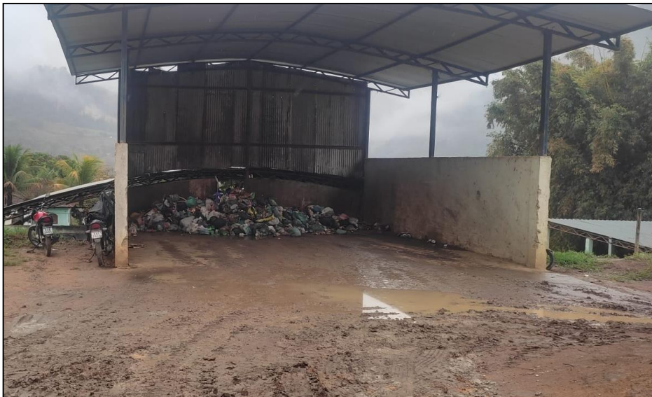
Figura 54 – Galpão de deposição dos resíduos sólidos recém-chegados na estação de triagem e transbordo
