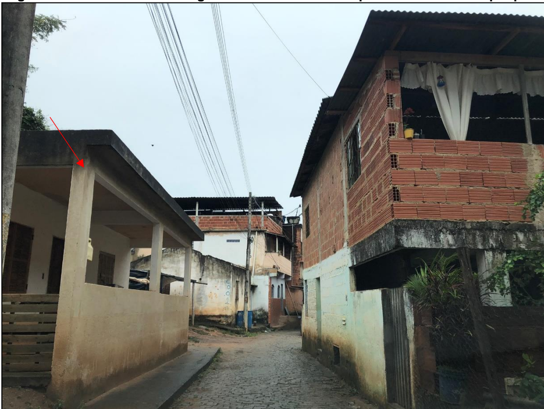
Figura 110– Evidências de alagamento em residências próximas ao Rio Paquequer.
