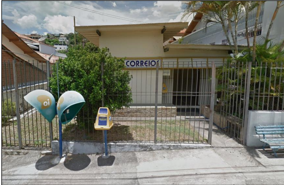
Figura 84 – Agência de Correios do Município de Sumidouro
