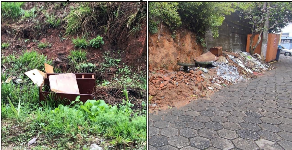
Figura 78 – Descarte irregular de resíduos volumosos
