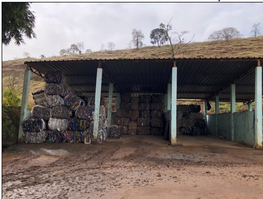
Figura 60 – Local de acondicionamento dos materiais recicláveis pós enfardamento.
