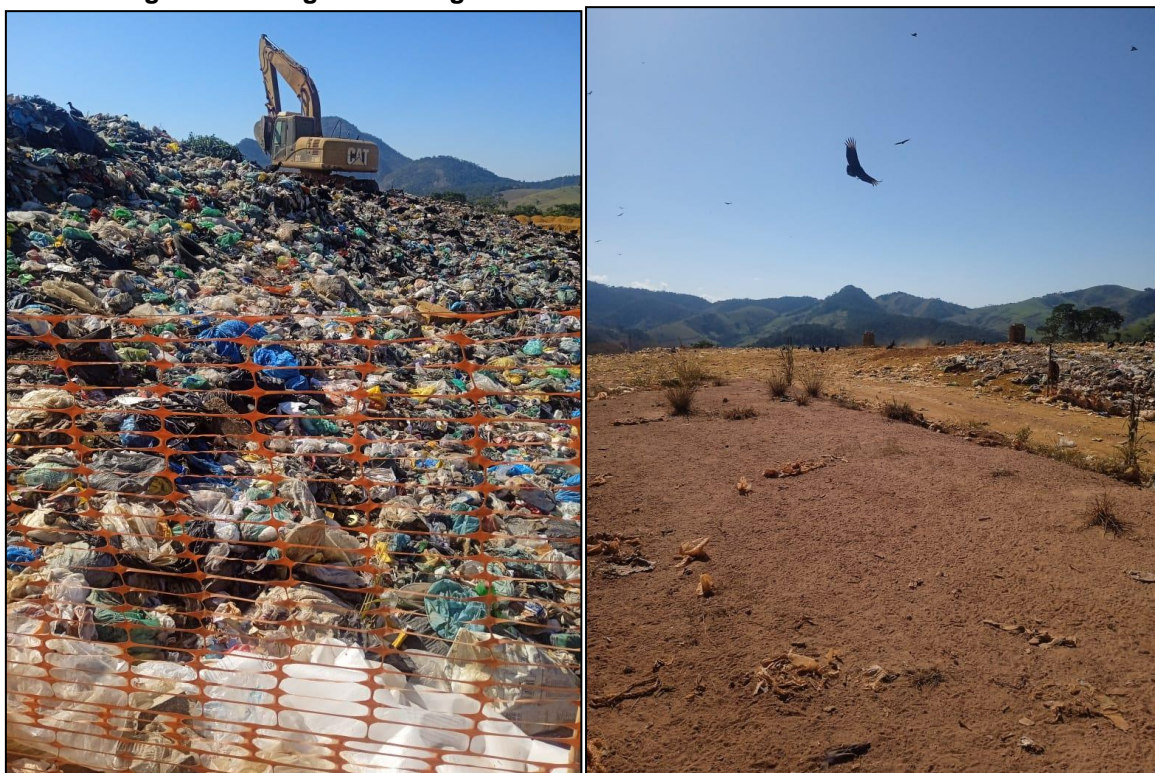
Figura 64 – Registros fotográfico da área do aterro sanitário de Além Paraíba
