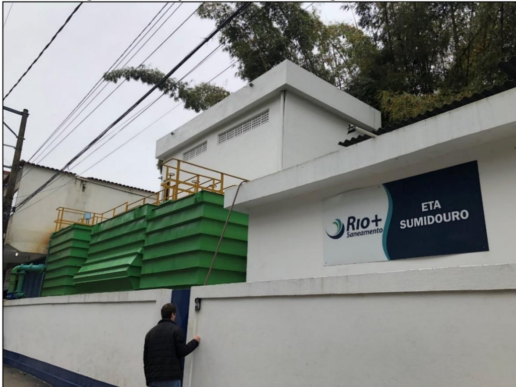
Figura 71 – Estação de Tratamento de Água de Sumidouro
