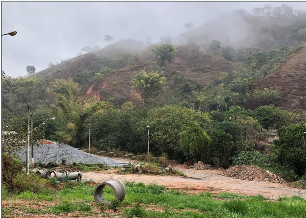
Figura 76 – Área de disposição dos resíduos da construção civil
