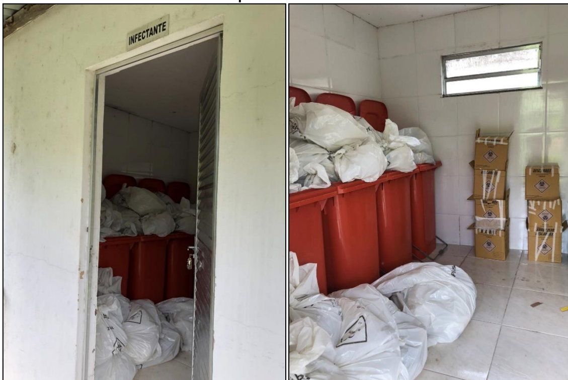
Figura 91 – Abrigo temporário das lixeiras de resíduos de serviços de saúde – Hospital Municipal Dr. João Pereira Martins
